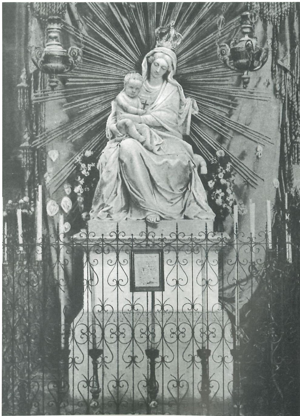
12. La statua della Madonna del Rimedio provvisoriamente collocata nella chiesa del Gesù, dopo la demolizione della chiesa di via Giulia
