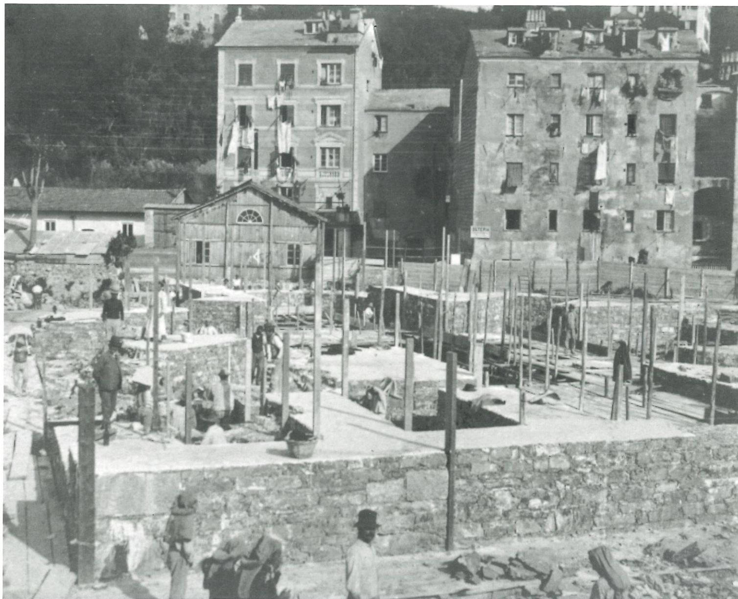
13. Il cantiere della nuova chiesa in località Mondo Nuovo oggi piazza Alimonda (23 maggio 1902)
